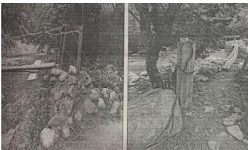
*“Figura N° 2 y N° 3. Se observa que los cables de acero y cadenas que sostiene la estructura del puente peatonal colgante se encuentran enlazados a unas columnas empotradas en el suelo natural, y que en cualquier momento pueden fallar estos soportes haciendo colapsar la estructura”<sup>64</sup>.*
