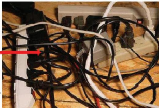
**Incendios estructurales internos por sobrecarga en los sistemas y/o disposición inadecuada del cableado**
