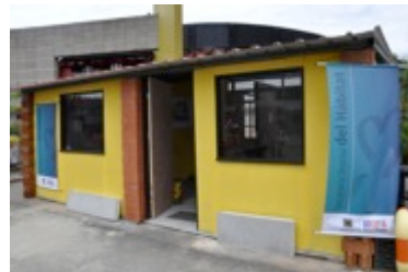
Laboratorio eco materiales: Muros fachada eco panel en pulpa de papel e icopor reciclados. Fuente SDHT 2013.
