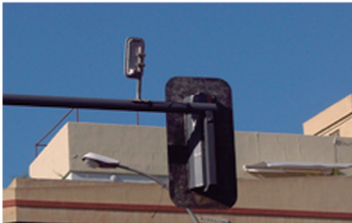
Figura 40: Picocelda instalada en semáforo y en fachada
