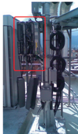
Figura 13: Unidad de Nodo B de UMTS Outdoor
