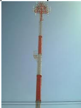
Figura 17: –Monopolo metálico
