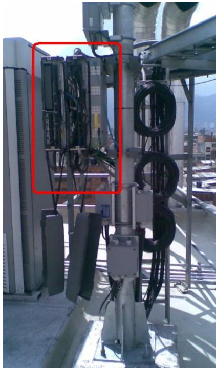
Figura 21: Unidad de Nodo B de UMTS Outdoor
