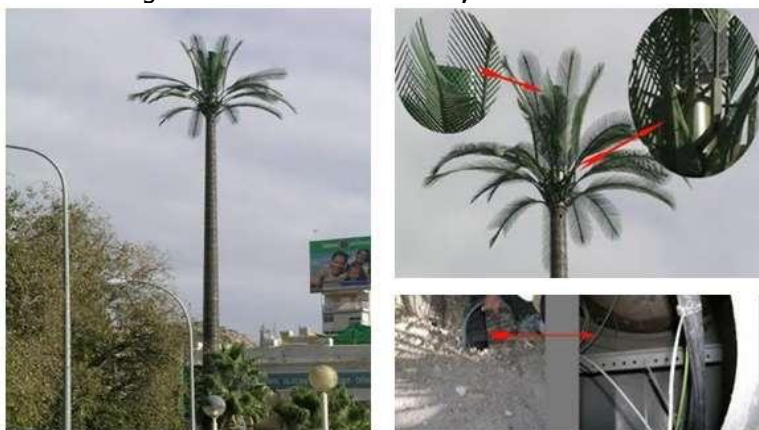
Figura 14: Foto Microcelda, cruce de vías
