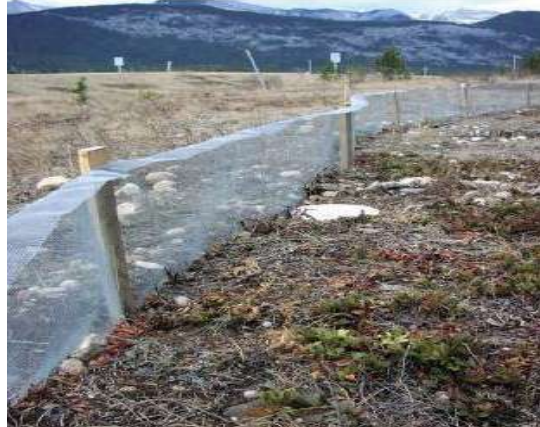
Figura 70: Barrera provisional para anfibios y reptiles.
