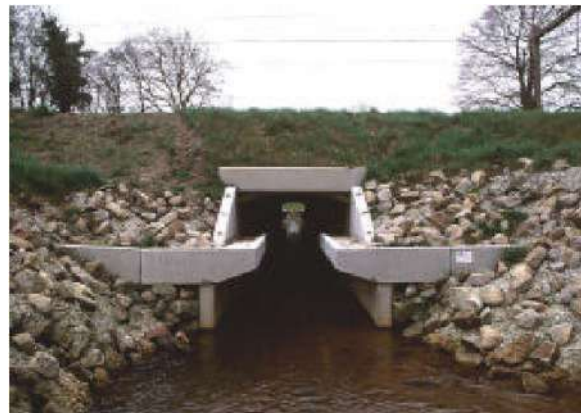
Figura 40: Box culvert con pasarelas a ambos lados.
