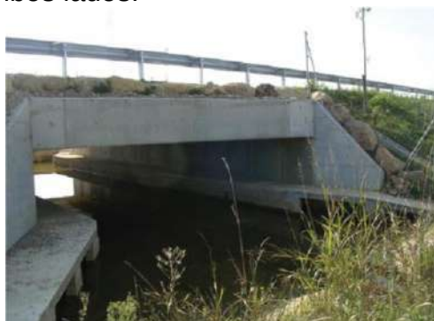
Figura 42: Box culvert con pasarelas a ambos lados.
